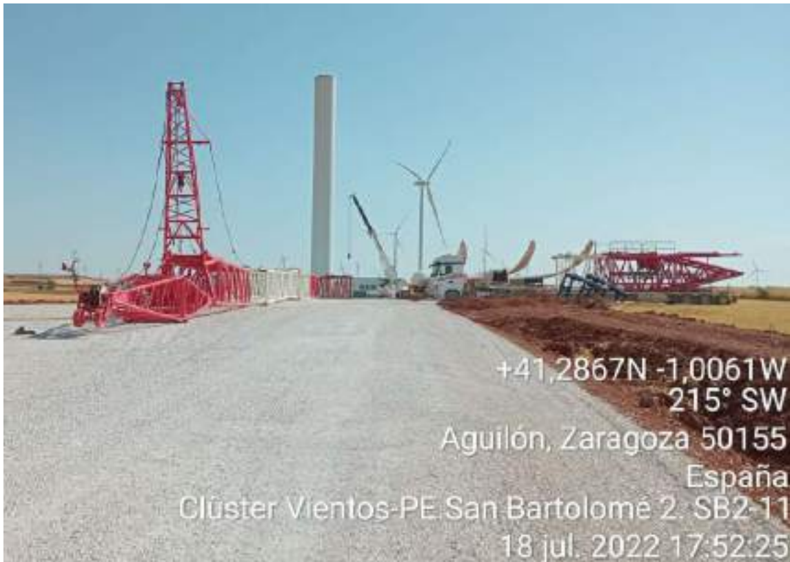
Imagen 2. Trabajos en plataforma de SB2-11
