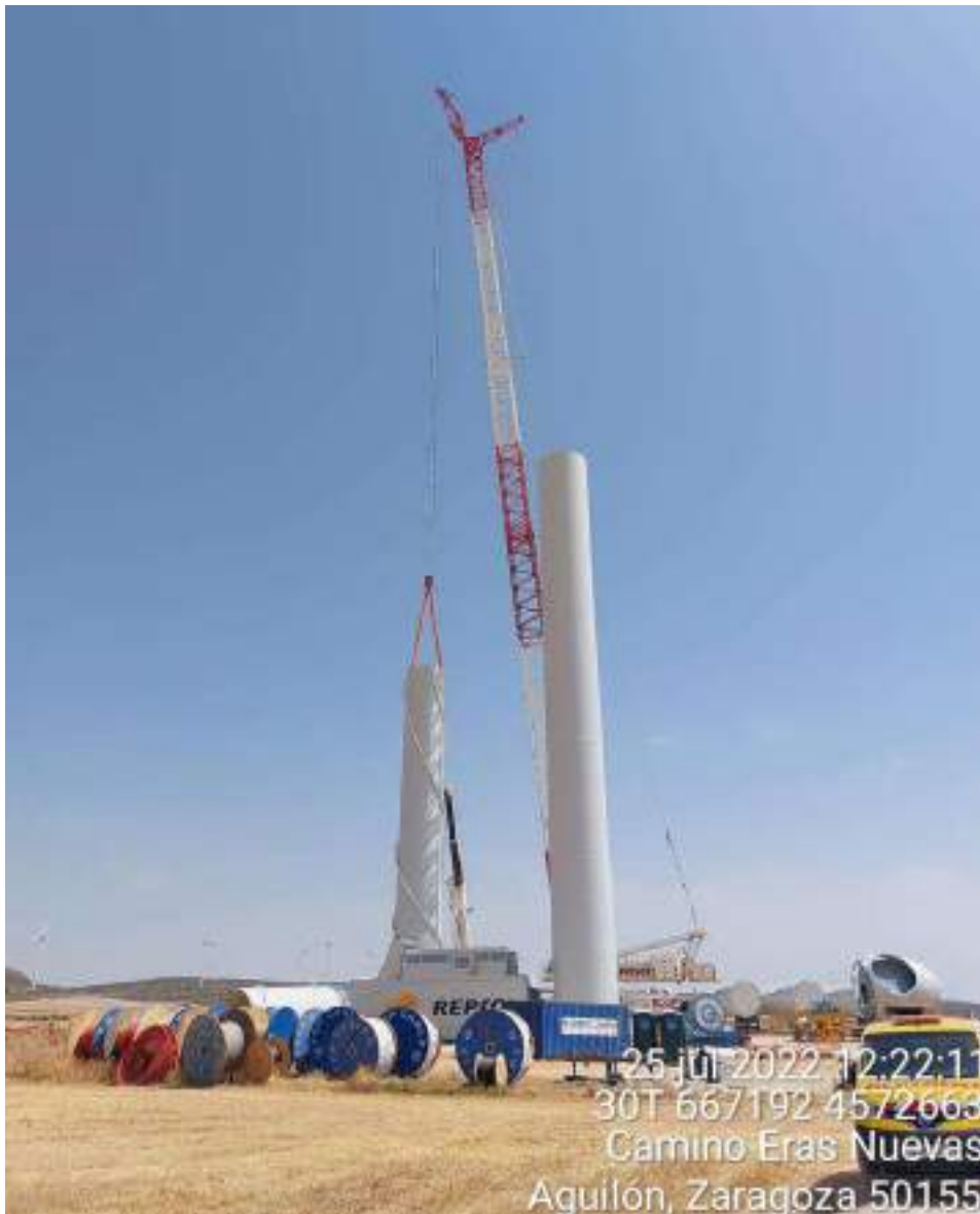
Imagen 2. Montaje del aerogenerador SB1-09
