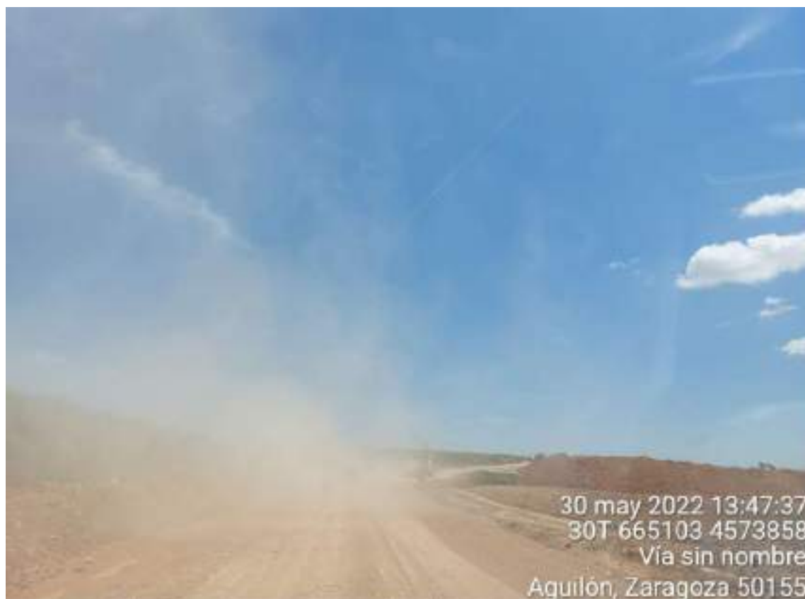
Imagen 1. Emisión de polvo debido al tránsito de maquinaria pesada en SBI-01.
