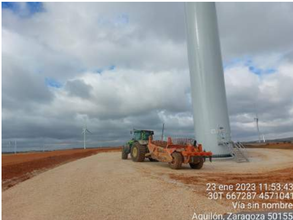
Imagen 2. Maquinaria realizando trabajos de restauración en PLX-02
