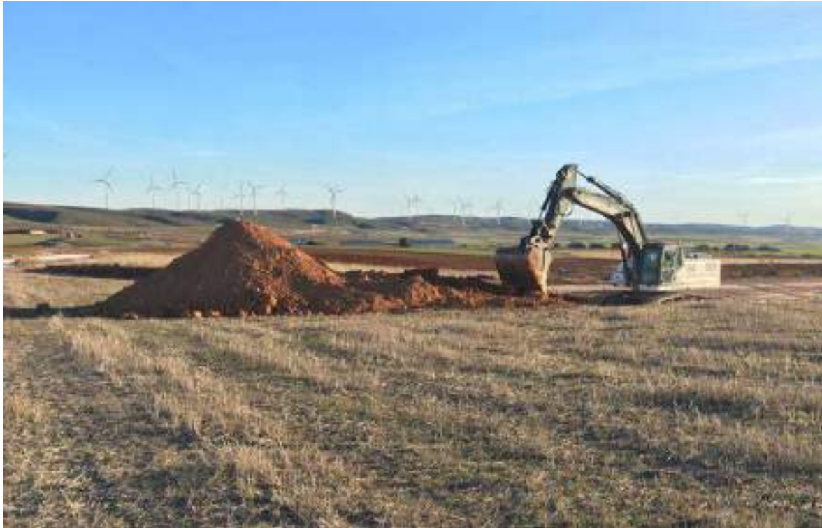
Imagen 1. Retroexcavadora trabajando en SBII-02
