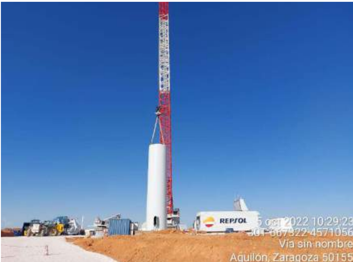
Imagen 4. Grúa colocando T1 en PLX-02.
