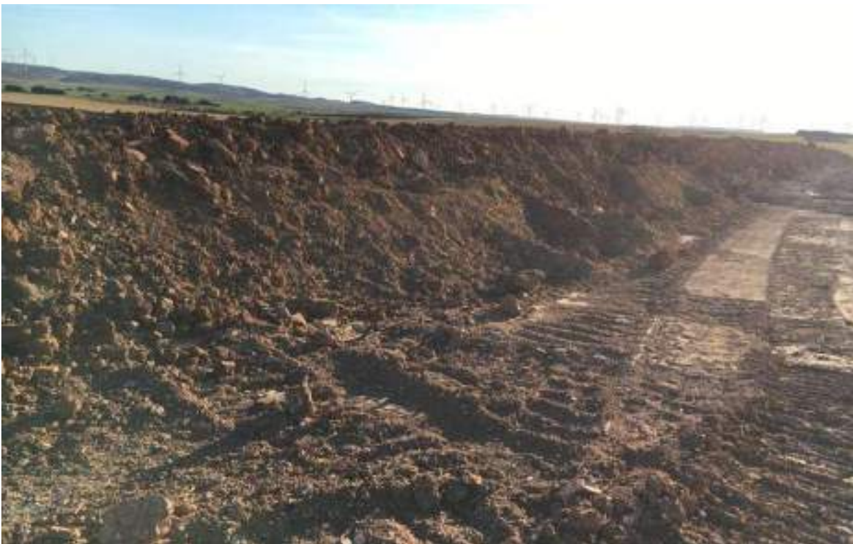
Imagen 4. Acopio de tierra vegetal en SBII-02
