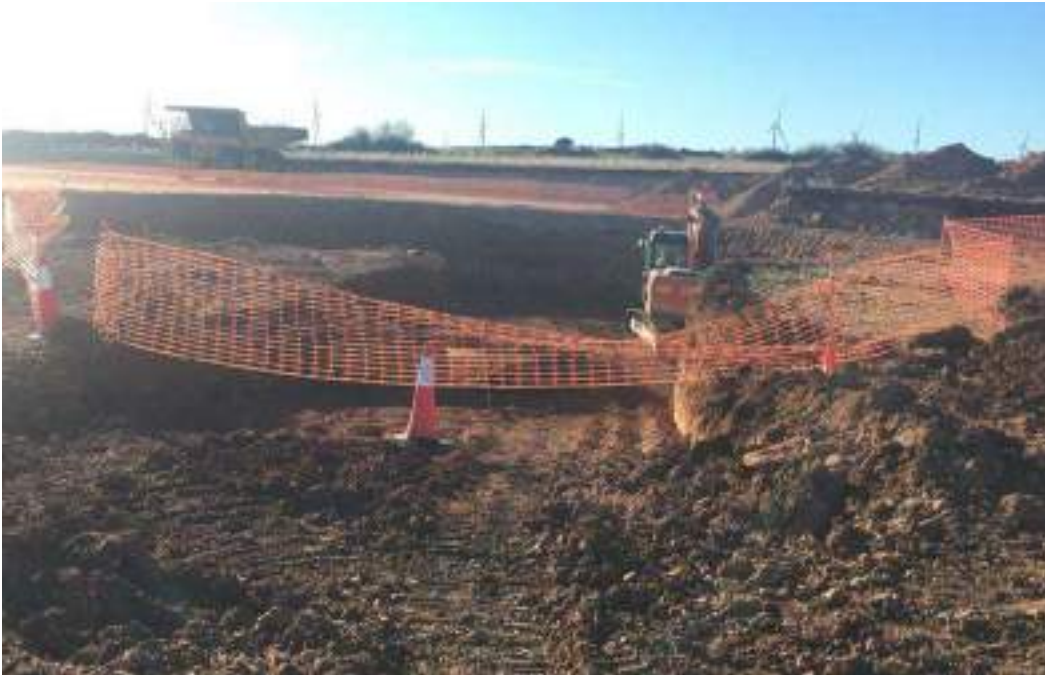
Imagen 2. Excavación zapata SBII-02
