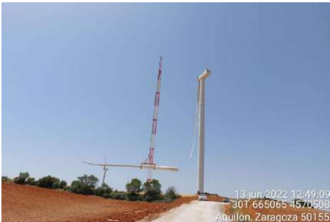
Imagen 3. Montaje del aerogenerador SB2-07.
