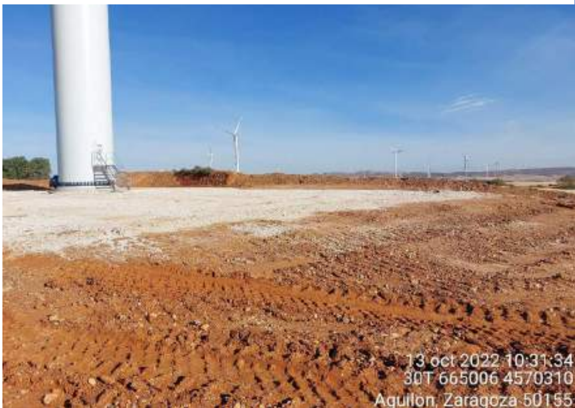
Imagen 4. Restauración ambiental posición SB2-07.
