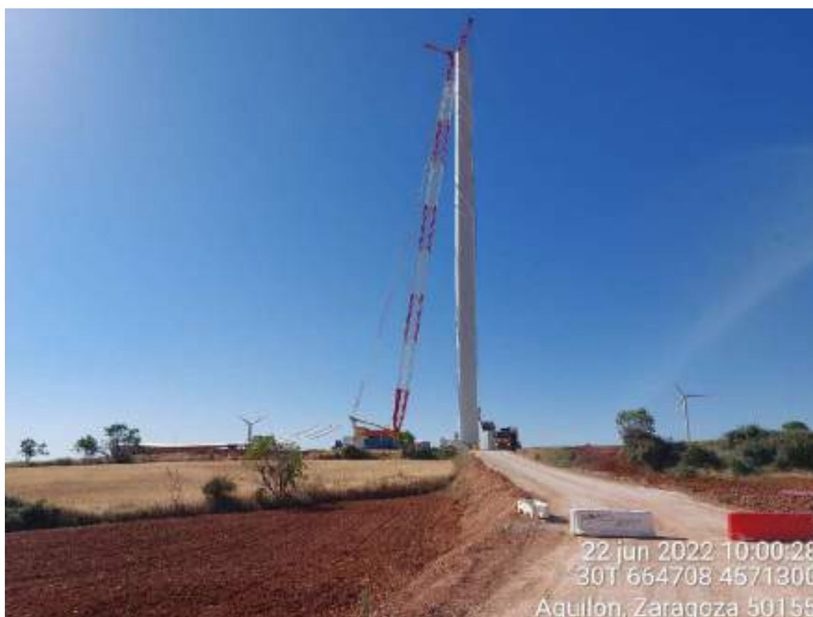
Imagen 1. Montaje de un aerogenerador
