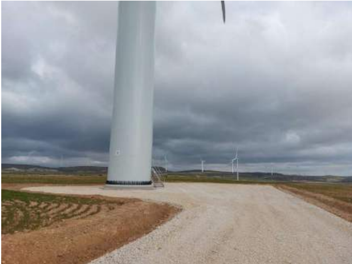
Imagen 3. Posición SB1-09 restaurada y repasada a falta de los últimos detalles
