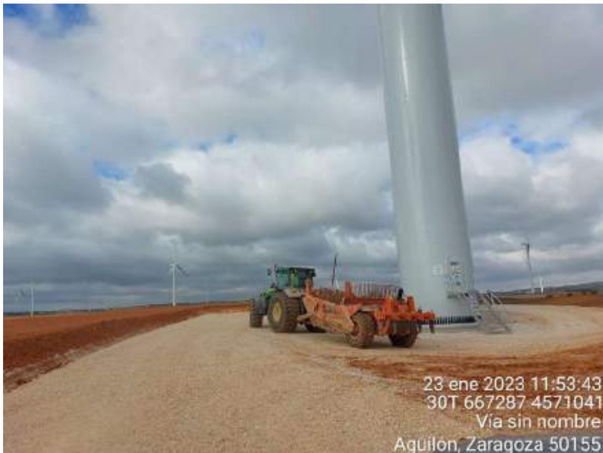
Imagen 2. Maquinaria realizando trabajos de restauración en PLX-02
