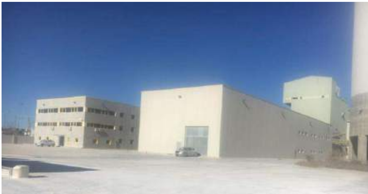
Imagen 4. Cementera en la que se instala el punto limpio
