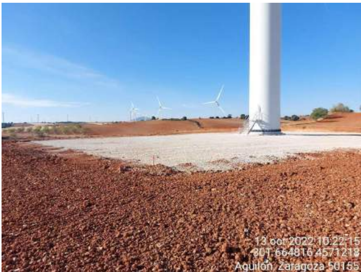
Imagen 3. Restauración ambiental posición SB2-04.
